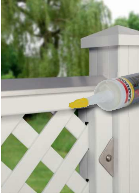
Designaufsatz Alu mit MS-Polymer-Kleber (1398) befestigen.
