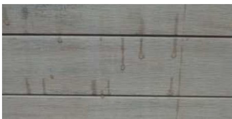
Fleckenbildung durch von Regen angelöste Partikel
